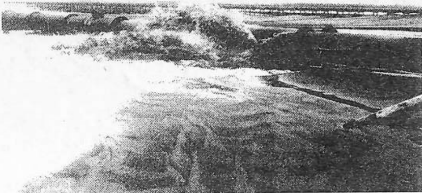
埋立て工事始動(昭和36年)。 五井浦から姉崎浦の各所に、沖から陸地に向かって太いパイプが延々と伸びている。工場建設予定地に沖合から埋立て用の砂を送るパイプが陸地に向かって施設されている。
